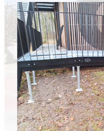
Einschlagfundament ProFix nach IVZ Norm
