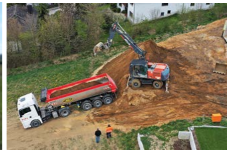
Art.-Nr.: 219300 - Entsorgungsschulung - Entsorgung und Umgang mit Abfällen und Bodenaushub im Straßenbereich
